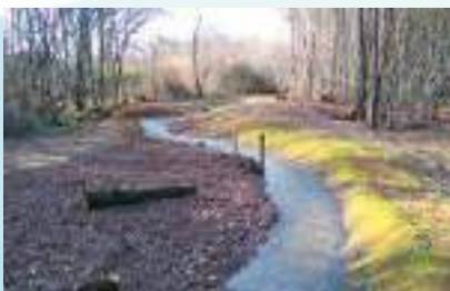
Après travaux : reméandrage pour allonger le tracé et réduire la pente afin de redonner au cours sa morphologie sinueuse et ses fonctionnalités
