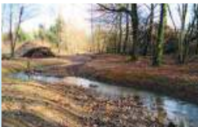
Après travaux : reméandrage pour allonger le tracé et réduire la pente afin de redonner au cours sa morphologie sinueuse et ses fonctionnalités
